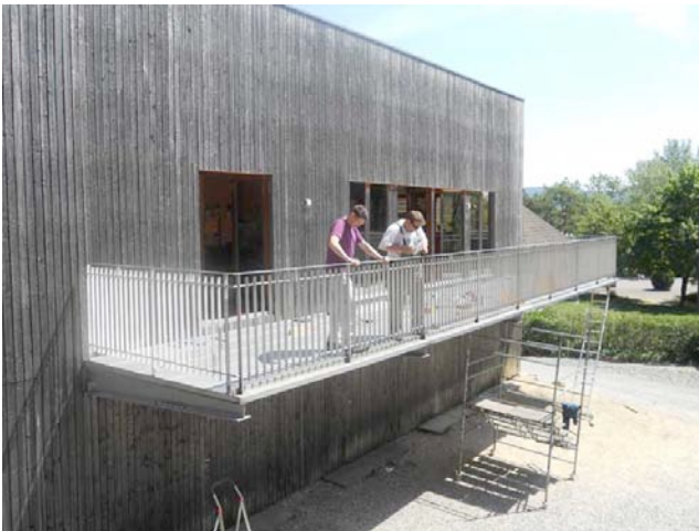
...schon steht das Geländer wieder
