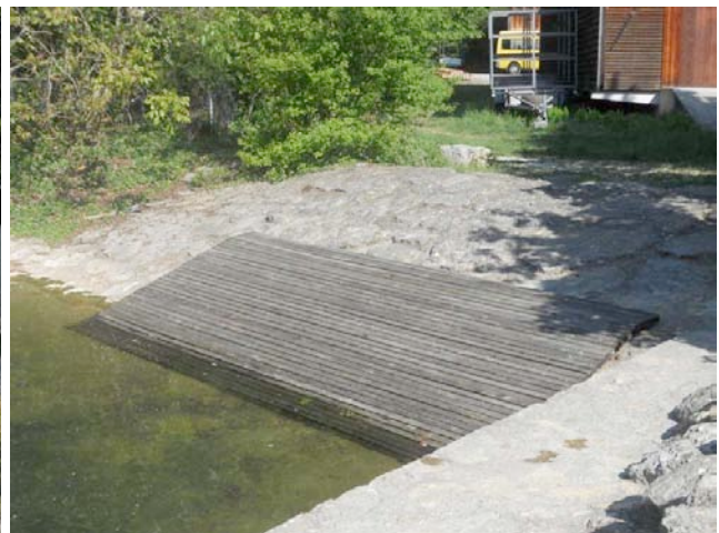
Recycelt: Die alten Balken als Bootsrutsche!
