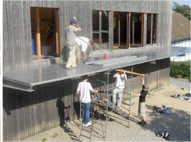
...die Metallabdeckung wird montiert
